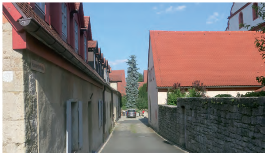
Altbausubstanz im Altort Tüchelhausen
