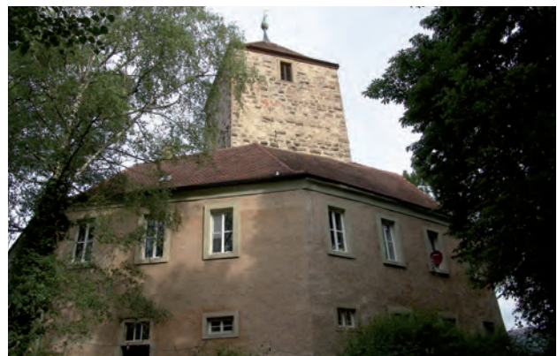
Ehem. Wasserschloss in Erlach
