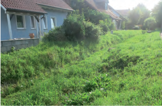
Entwässerungsgraben in Tüchelhausen
