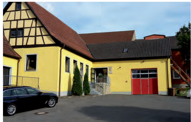
Feuerwehrhaus in Zeubelried
