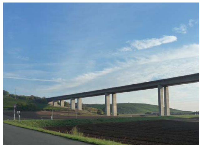
Autobahnbrücke über das Maintal bei Obernbreit
