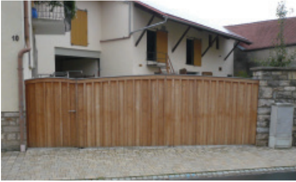
Hoftoranlage aus Holz mit angrenzender Mauer aus Muschelkalk
