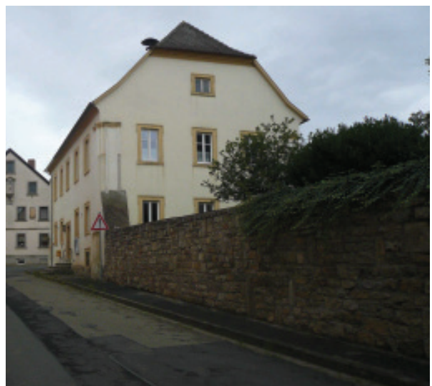
Ehemaliges Pfarrhaus, dann Rathaus Duttenhöferstraße 1 (Baudenkmal)
