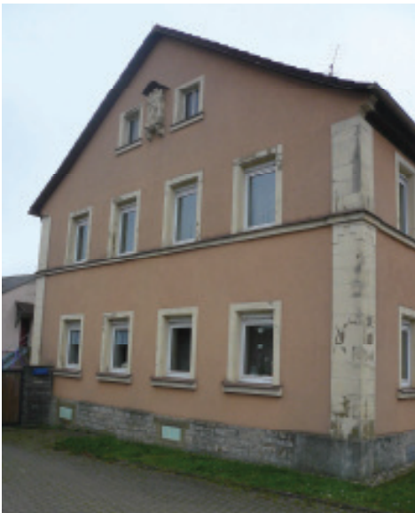
Charakteristische, erhaltenswerte Fassadendetails erschweren eine Außendämmung
