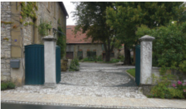
Hoftoranlage aus Holz mit Torpfeilern
