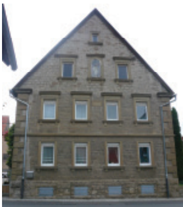
Natursteinmauerwerk aus Muschelkalk
