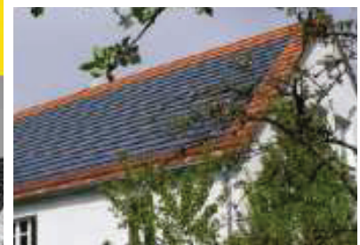
Dach mit Solarziegeln oder versenkten Flachkol- lektoren eindecken
