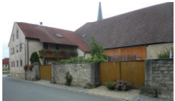
Hoftoranlage aus Holz mit Torpfeilern und Mauer aus Muschelkalk
