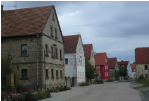
Dorfstraße in Richtung Osten
