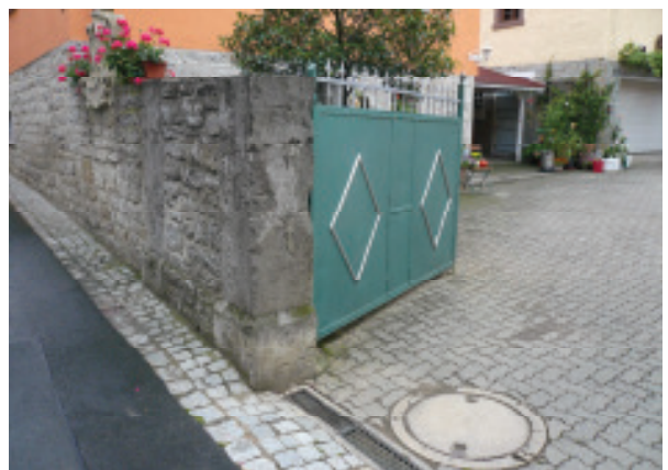
Hoftoranlage aus Metall und Mauer aus Muschelkalk
