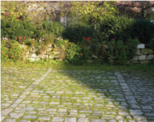
Hoffläche mit Natursteinpflaster
