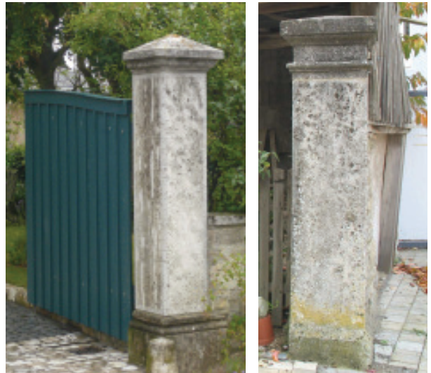
Profilierte Torpfeiler aus Naturstein
