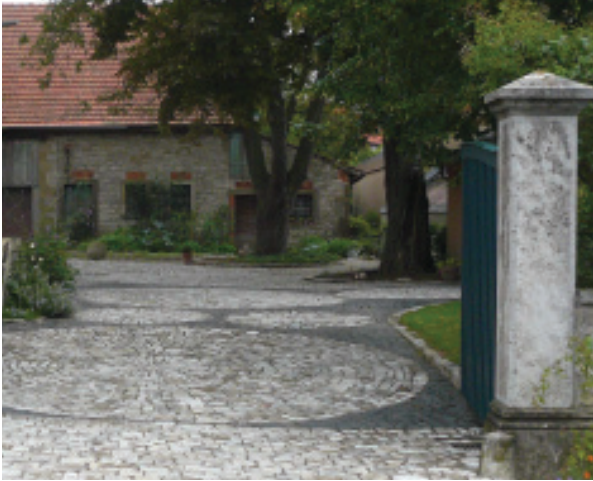
Hoffläche mit Natursteinpflaster, Hofbäumen und Grünflächen gegliedert
