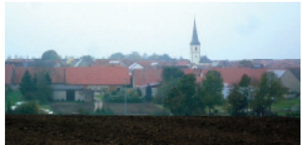
Ortsansicht von Osten mit Scheunenriegel
